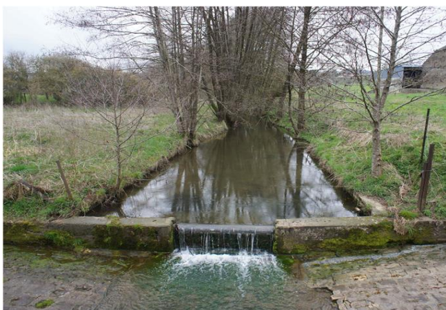
Foto gegen Fließrichtung
