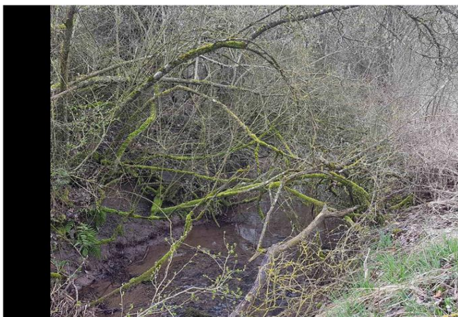
Foto gegen Fließrichtung
