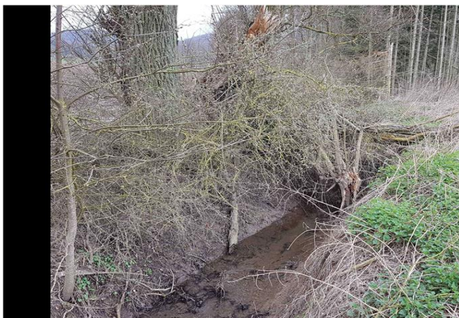
Foto gegen Fließrichtung
