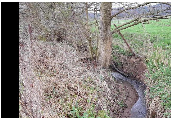
Foto gegen Fließrichtung
