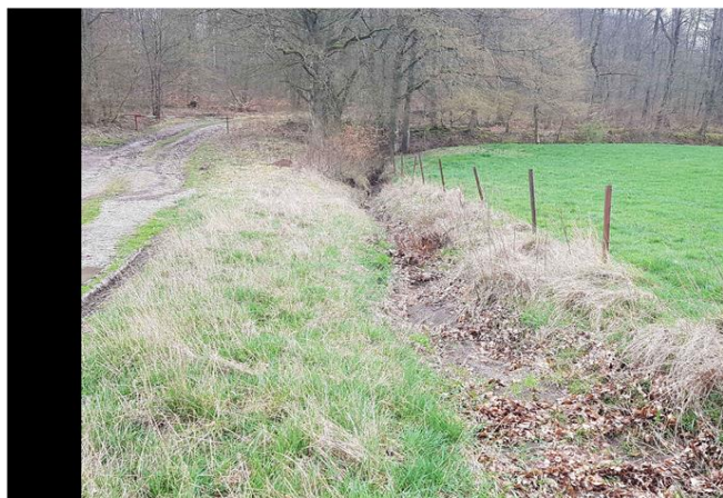
Foto gegen Fließrichtung
