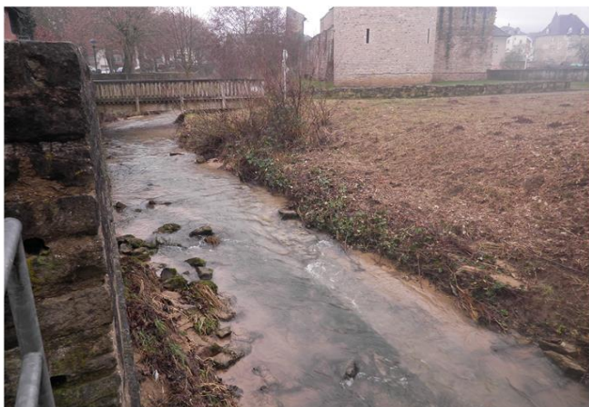
Foto gegen Fließrichtung
