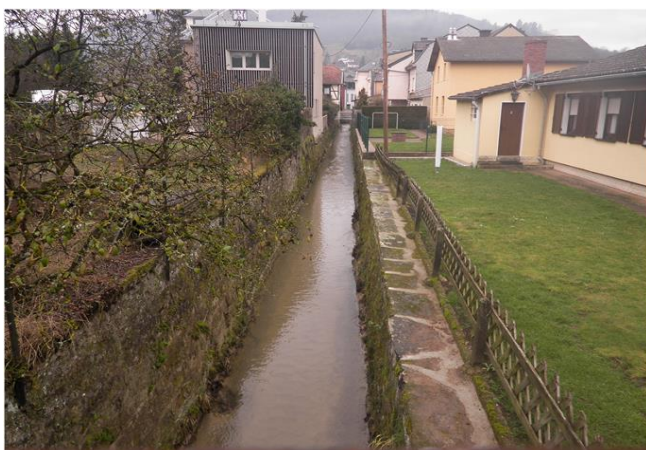
Foto gegen Fließrichtung
