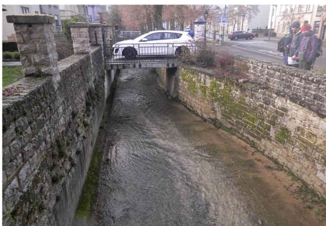
Foto gegen Fließrichtung
