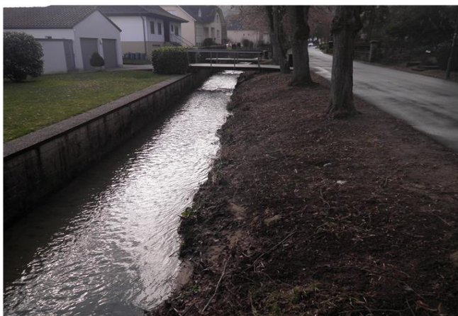
Foto gegen Fließrichtung
