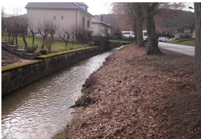
Foto gegen Fließrichtung
