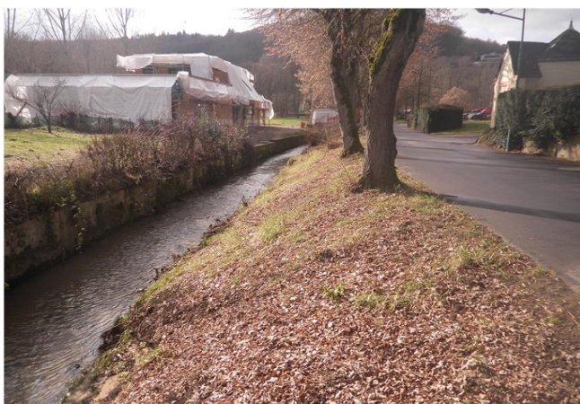
Foto gegen Fließrichtung
