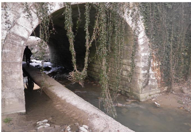
Foto gegen Fließrichtung
