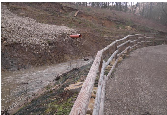
Foto gegen Fließrichtung
