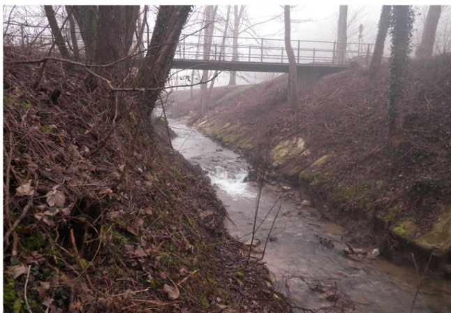
Foto gegen Fließrichtung
