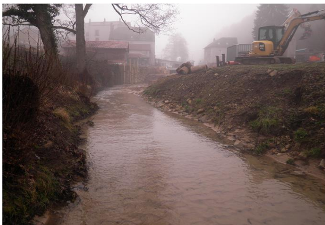
Foto gegen Fließrichtung
