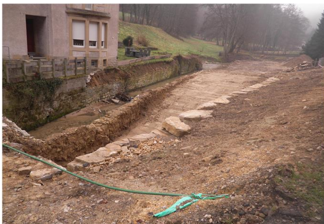
Foto gegen Fließrichtung
