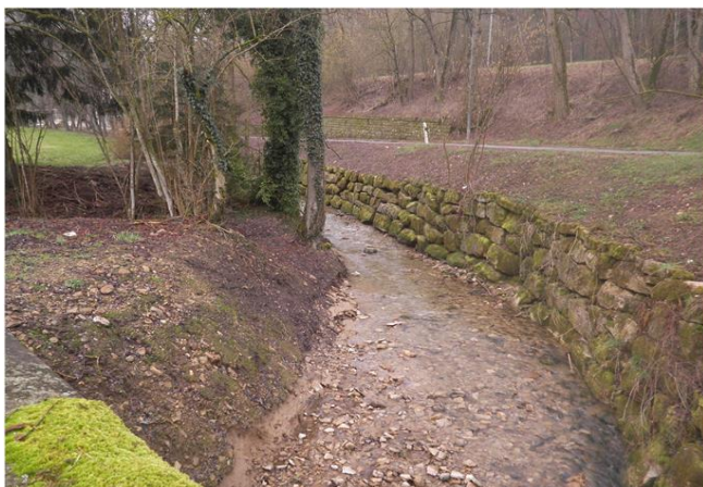
Foto gegen Fließrichtung
