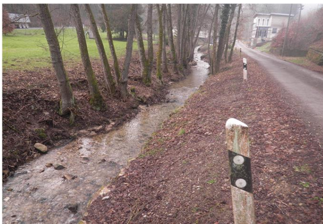
Foto gegen Fließrichtung
