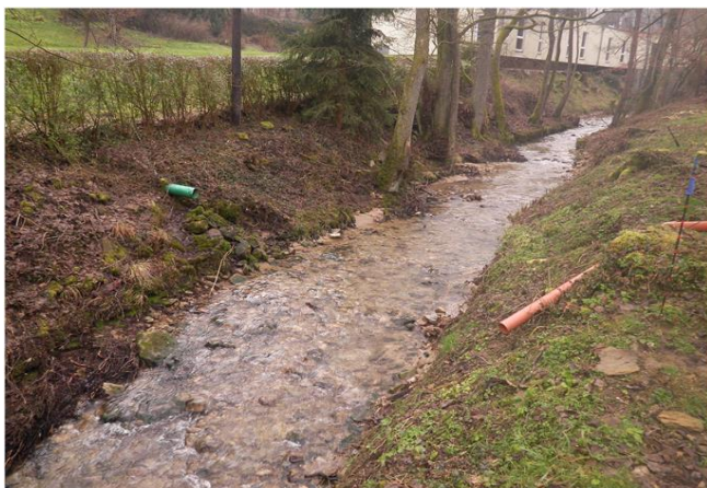
Foto gegen Fließrichtung
