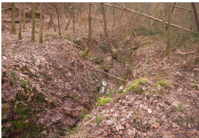
Foto gegen Fließrichtung
