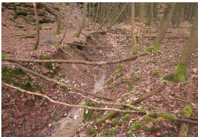
Foto gegen Fließrichtung
