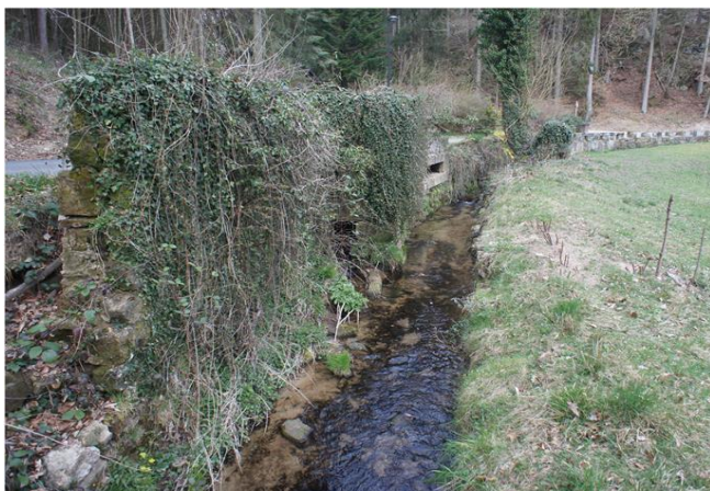
Foto gegen Fließrichtung
