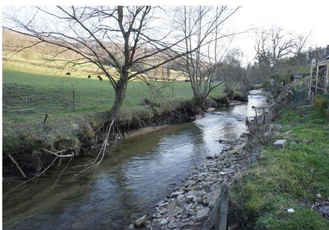
Foto gegen Fließrichtung
