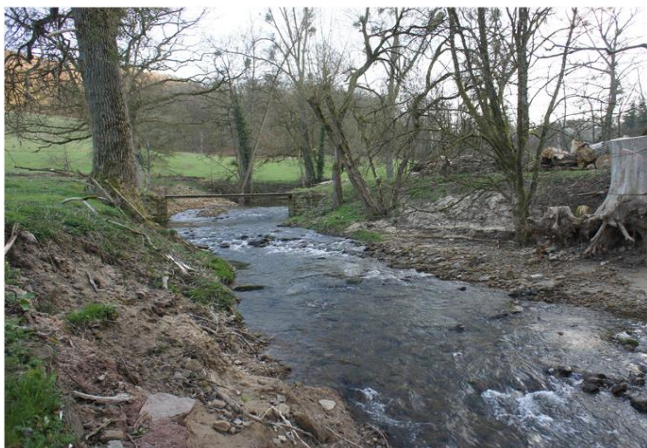
Foto gegen Fließrichtung
