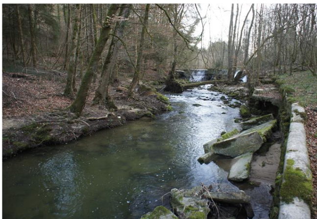
Foto gegen Fließrichtung
