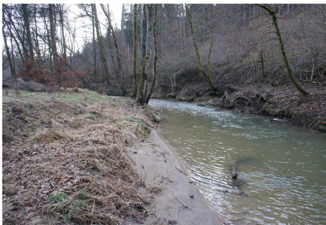
Foto gegen Fließrichtung
