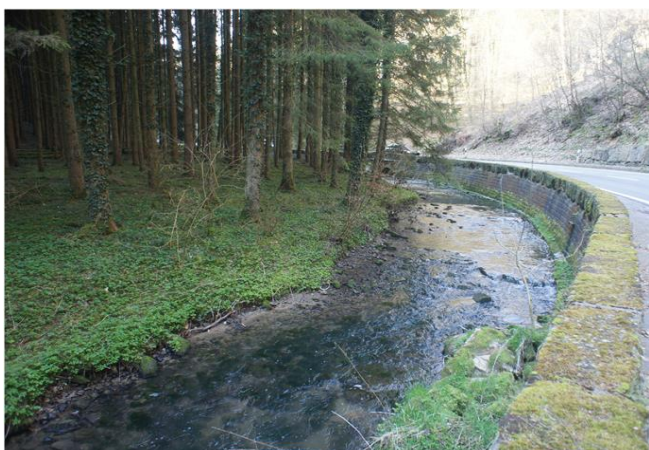
Foto gegen Fließrichtung
