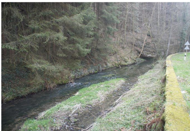
Foto gegen Fließrichtung
