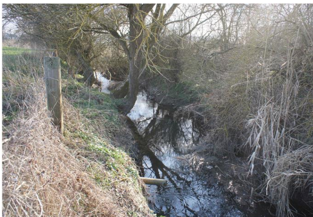
Foto gegen Fließrichtung
