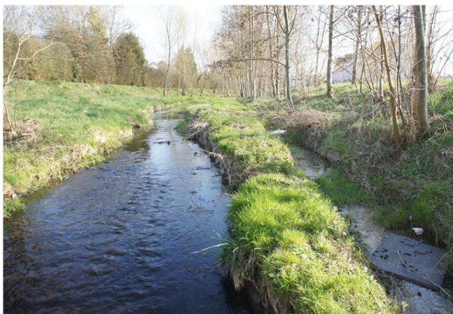
Foto gegen Fließrichtung
