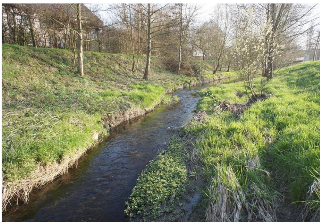
Foto gegen Fließrichtung
