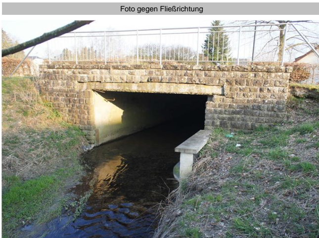
Foto gegen Fließrichtung
