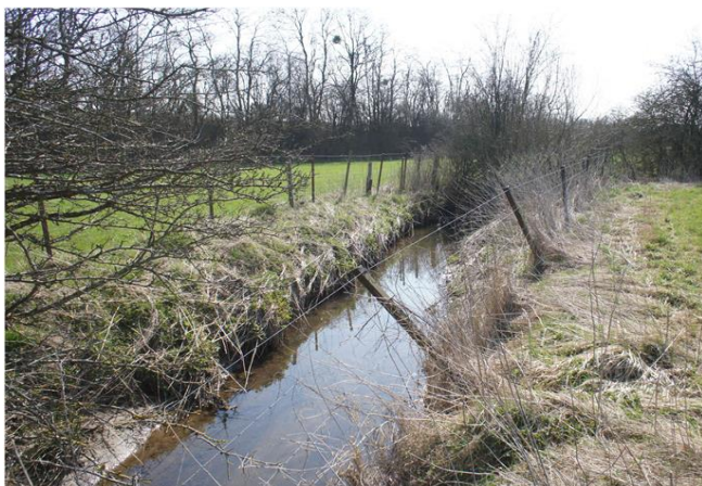
Foto gegen Fließrichtung
