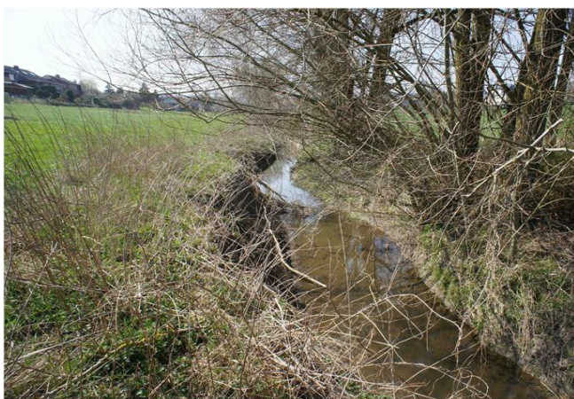
Foto gegen Fließrichtung
