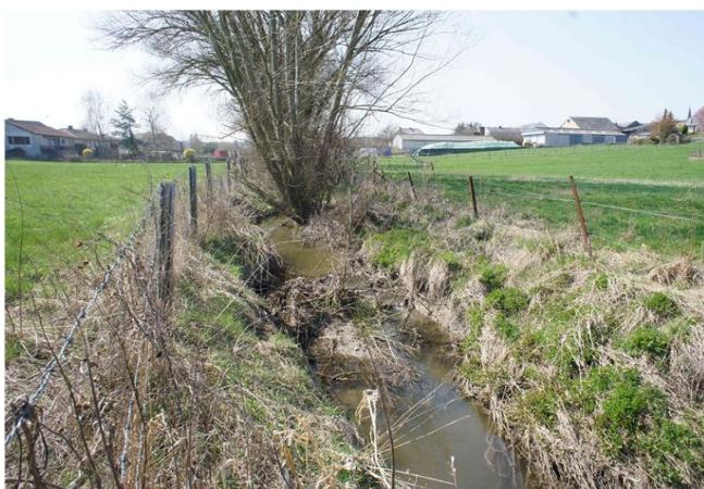
Foto gegen Fließrichtung
