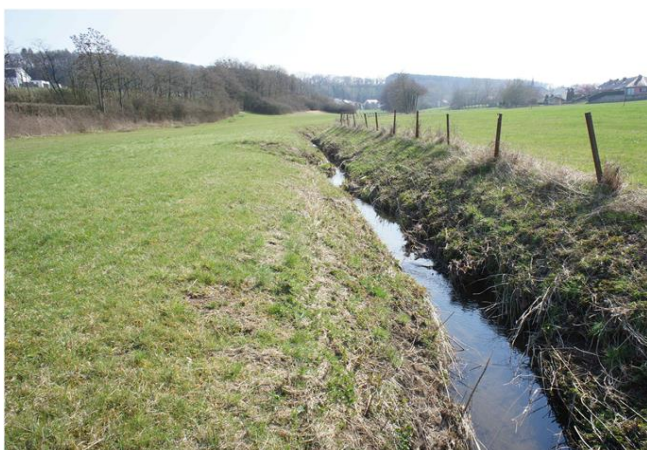
Foto gegen Fließrichtung
