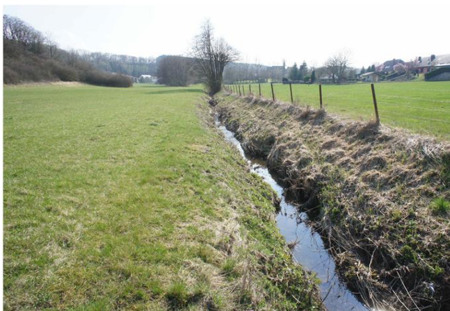
Foto gegen Fließrichtung
