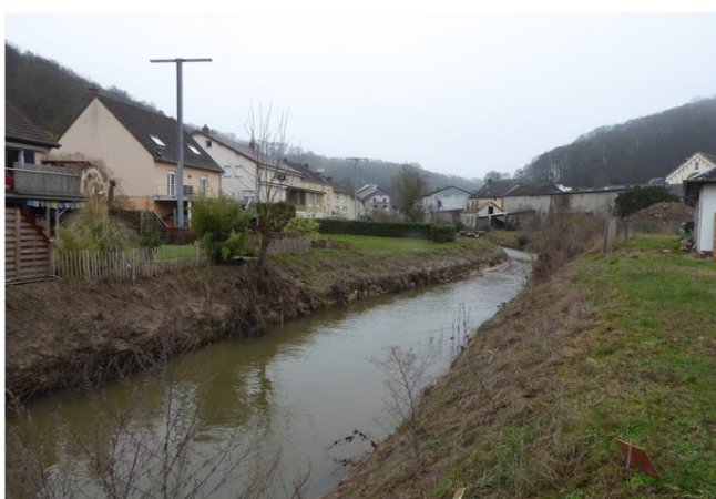
Foto gegen Fließrichtung
