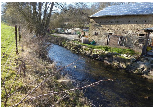
Foto gegen Fließrichtung
