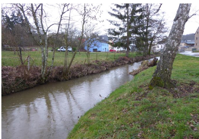
Foto gegen Fließrichtung
