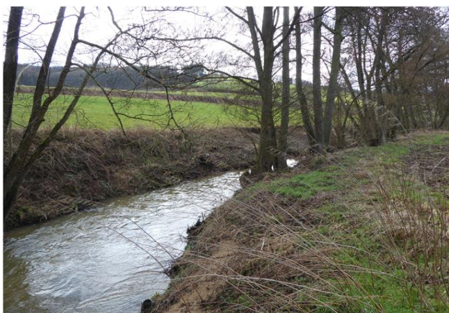
Foto gegen Fließrichtung
