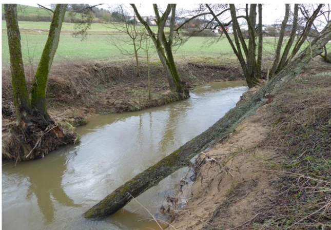
Foto gegen Fließrichtung
