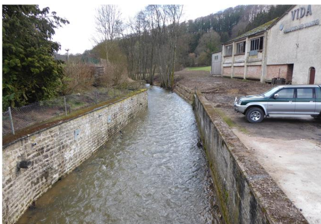
Foto gegen Fließrichtung
