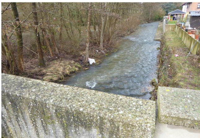
Foto gegen Fließrichtung
