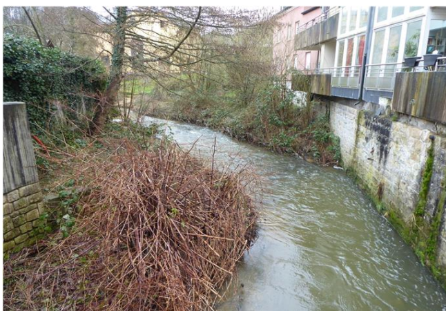
Foto gegen Fließrichtung
