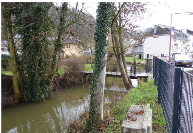
Foto gegen Fließrichtung
