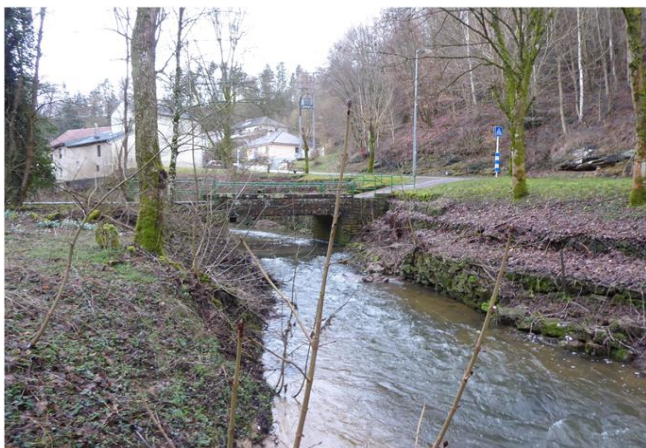
Foto gegen Fließrichtung
