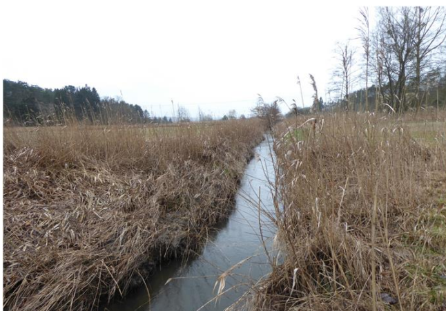
Foto gegen Fließrichtung
