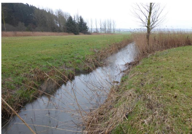
Foto gegen Fließrichtung
