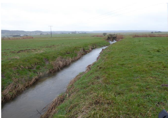
Foto gegen Fließrichtung
